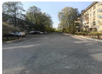
Ремонт придомовой территории д. Истомино ул.Г.Маргелова, дома №64,66
