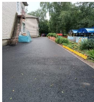
Ремонт асфальтобетонного покрытия территории МБДОУ «Детский сад №27»
