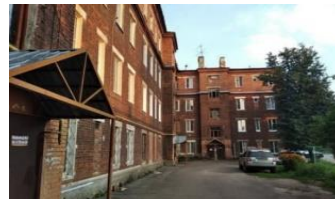
фото объекта «до»
