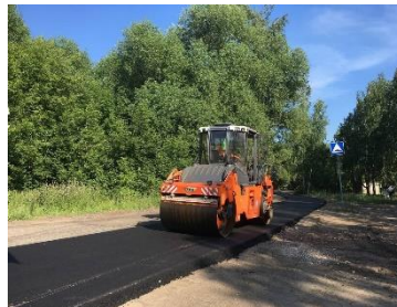
Ремонт дорог округа в 2024 году
