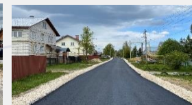
р.п. Гидроторф ул. Октябрьская
