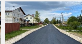
р.п. Гидроторф ул. Октябрьская
