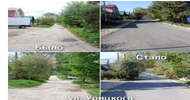
Ремонт автомобильных дорог г. Балахна
