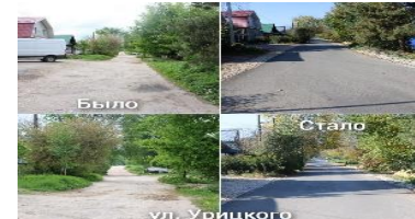
Ремонт автомобильных дорог г. Балахна
