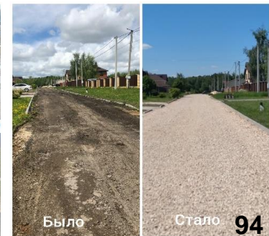
Ремонт автомобильной дороги по ул.Радужная г.Балахна
